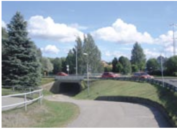
Cirkulationsplats Norra Obbolavägen/Tegsvägen. Gång- och cykelunderfart.
