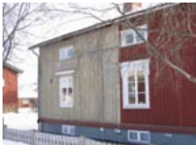
Borttagning av plastfärg pågår.
