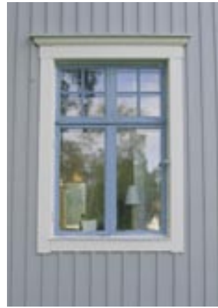
1920-tal. Korspostfönster med tätspröjsad överdel och profilerat överstycke.
