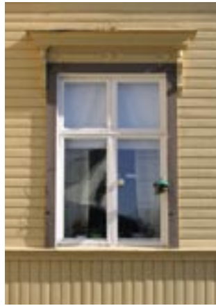
1890–1920. Korspostfönster med konsolburet profilerat överstycke.
