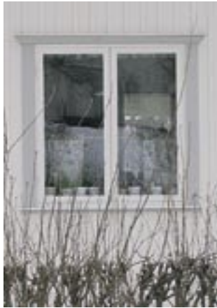
1930–1950. Tvåluftsfönster. Stående foder, profilerade lister över och smal list under.
