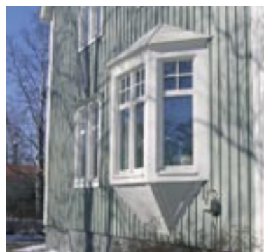
1920-tal. Burspråk med korspostfönster.
